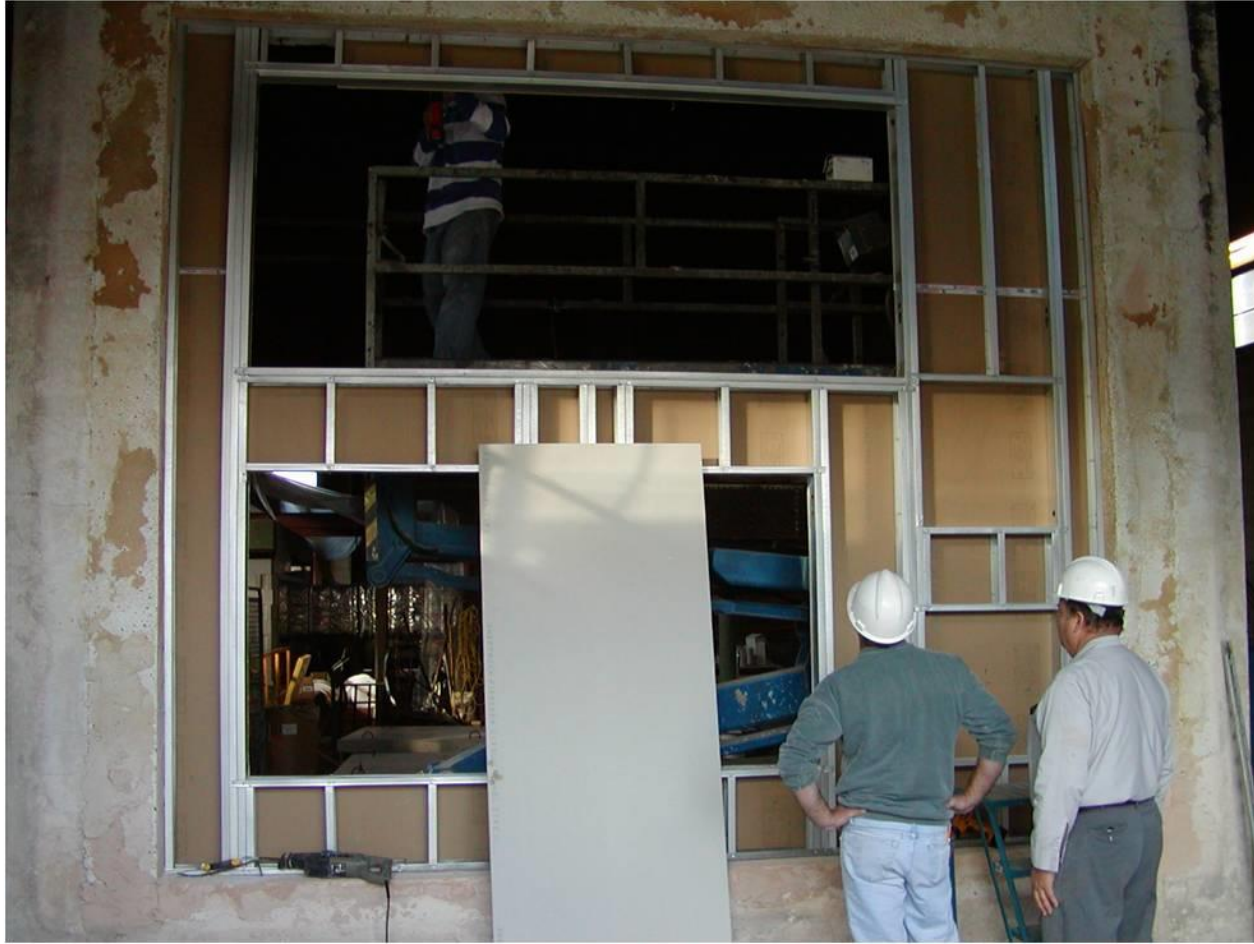
METAL STUD / GYPSUM FIREWALL
