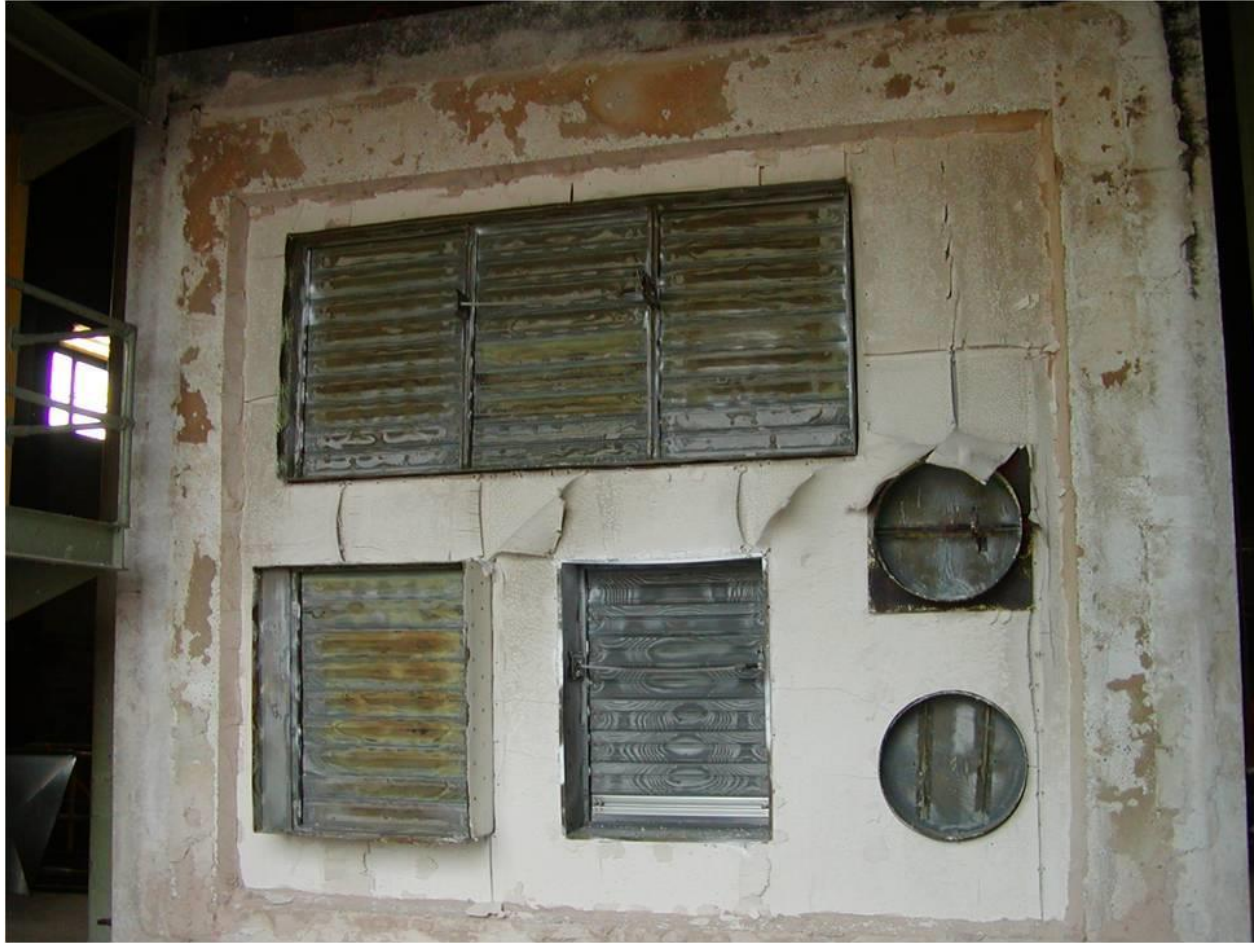
Côté feu juste avant le jet de tuyau
