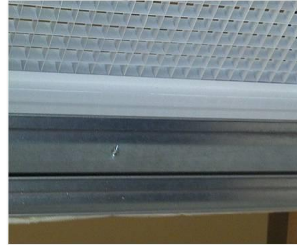
Vis fixée dans le rail du rideau du clapet
